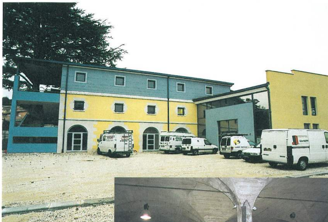
Vue d'ensemble du bâtiment.
