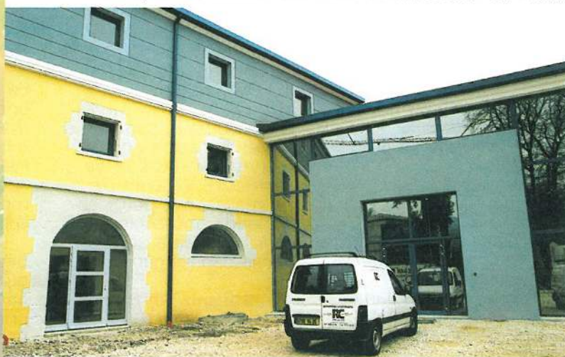
Vue de l'entrée extérieure.
